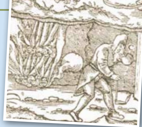
Durch Erhitzen und schnelles Abkühlen lockerten die Bergleute das Felsgestein (Darstellung aus dem 16. Jahrhundert).
